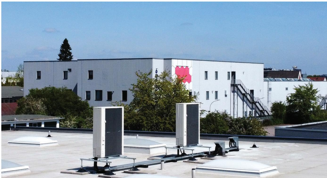
Aufstellung der Außeneinheiten auf dem Flachdach
