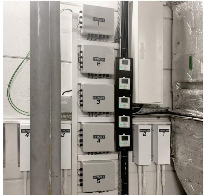
Systemregelung über EXV-Kits und Kabelfernbedienungen
