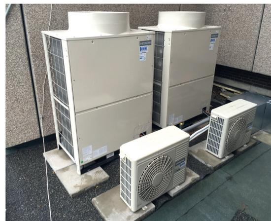
Bei verschiedenen Klimatisierungsanforderungen im Gebäude werden zwei 2-Leiter Wärmepumpeneinheiten benötigt. Durch den Einsatz der kompakten Utopia IVX-Außeneinheiten für den EDV-Raum konnte die Standfläche um 40% reduziert werden.
