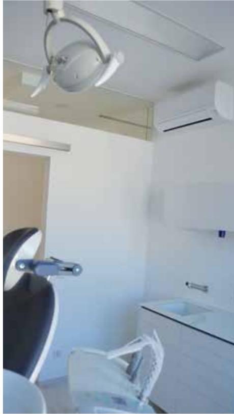
über die Versorgungsleitungen die Inneneinheiten versorgt und den Kühl- und Heizbedarf der Inneneinheiten sicherstellt. Je nachdem wie viele Inneneinheiten des Gesamtsystems Leistung anfordern, ermittelt die Inverter-Elektronik den genauen Bedarf und gibt genau diese Leistung für die laufenden Inneneinheiten frei.
